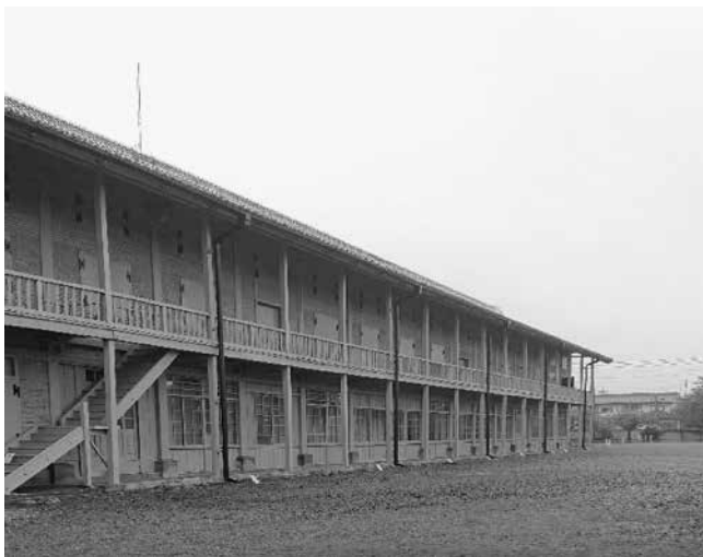
（実地調査の様子・撮影：小金澤）
