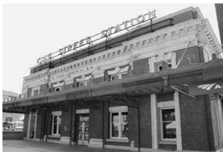
*キングストリートステーション (以下 King Street Station)
