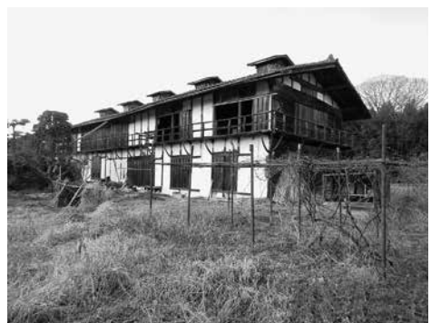
写真5・6 川場村に残る養蚕民家（上：数少なくなった茅葺き兜造り、下：腰屋根が5つ付いている民家・12月13日）
